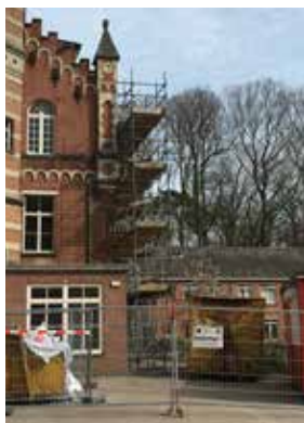
Hier wordt gewerkt!
